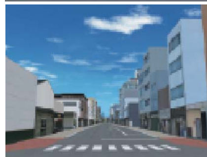
電柱・アーケード撤去後
